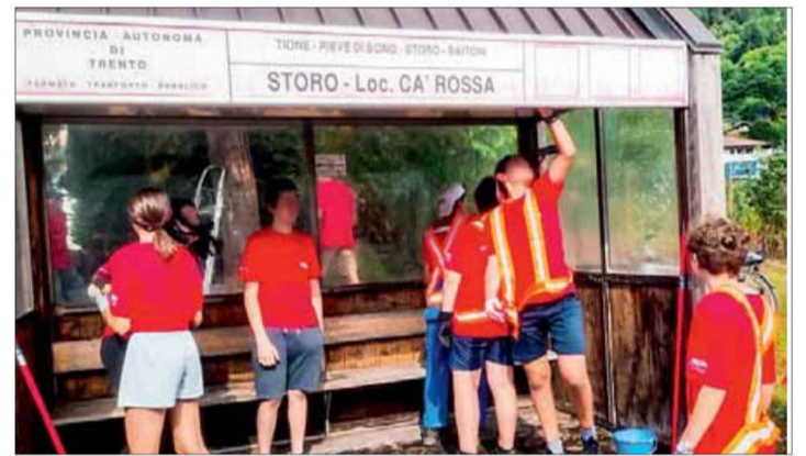
Ragazzi impegnati a Storo nella manutenzione di una pensilina
